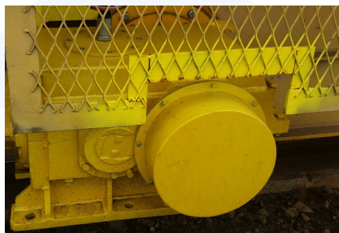
Opsteekkast na montage. Beschermkap over krimpverbinding
